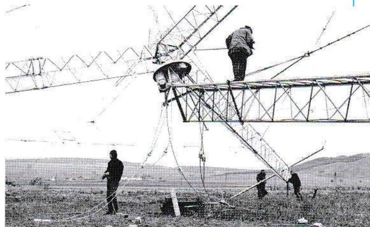
1972: Montage der logarithmisch-periodischen Richtantenne „Granger“.
